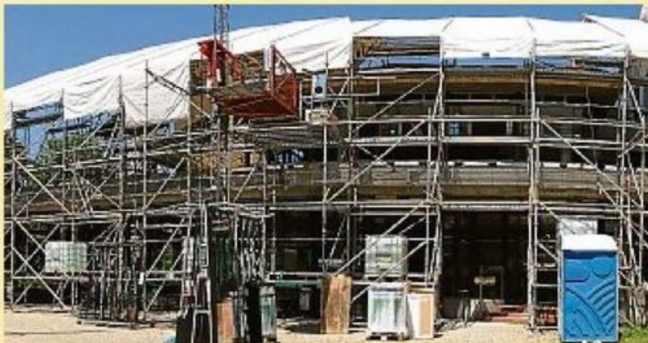
Das Wetterschutzdach am Gabriel-von-Seidl-Gymnasium Bad Tölz ermöglichte einen schnelleren Sanierungsfortschritt. Foto: tka
