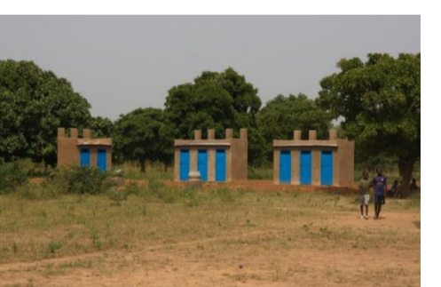
Latrinen (erbaut von UNICEF)
