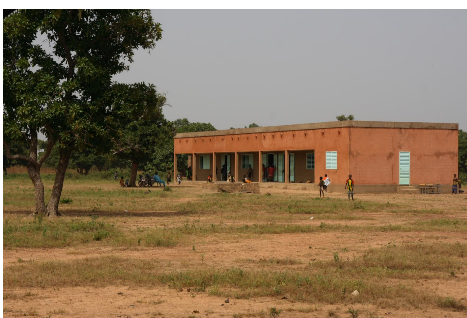
Foto 3: Schulgebäude in Sagla mit 3 Klassenräumen
